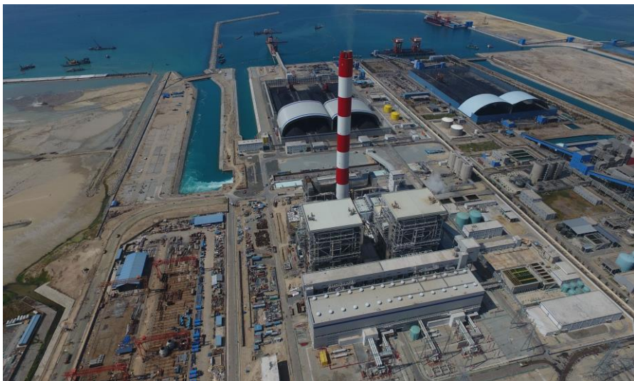
建设中的永新一期BOT火电项目
